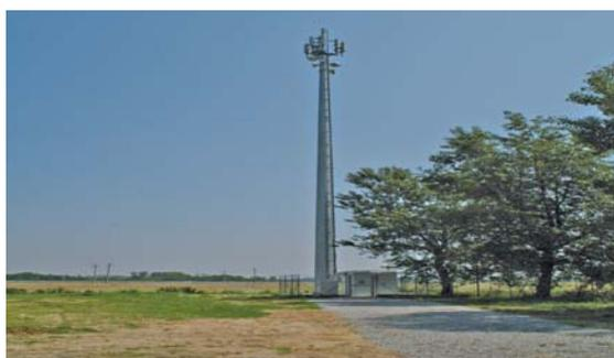
del tipo "raw land", comprende un palo porta antenne dell'altezza di trenta metri, sulla cui sommità (a 27 e 28 metri dal suolo) sono collocate quattro parabole con diverso orientamento direzionale.
