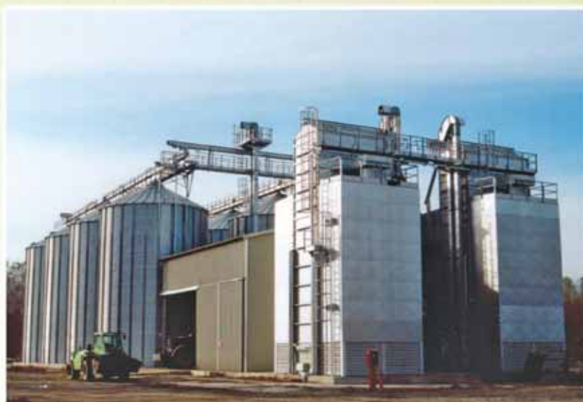
Impianto di essiccazione e stoccaggio da Ton. 4700
