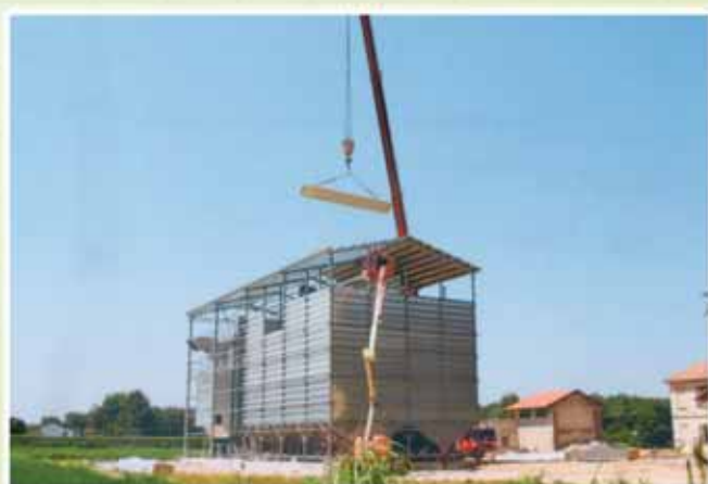
Impianto di essiccazione e stoccaggio con celle quadrate su tramogge Ton. 970
