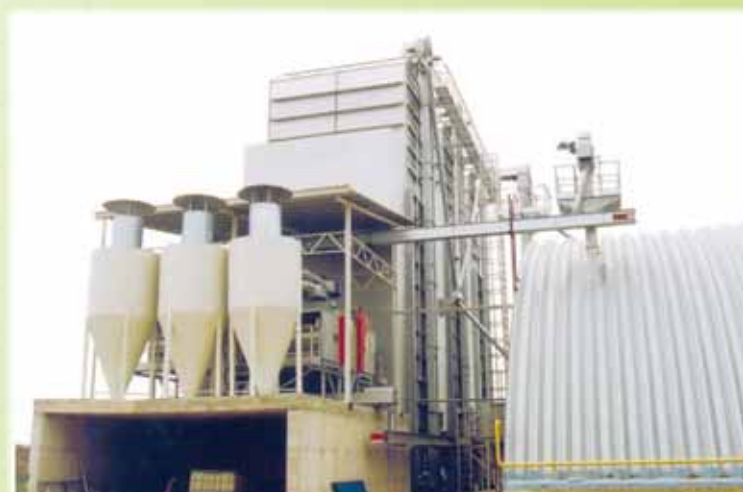
Impianto di essiccazione e stoccaggio con pulitura e cicloni per polveri Capacità Ton. 10000
