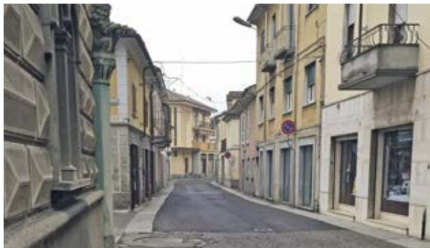
Il tratto di via XX Settembre dove verrà effettuata la posa del porfido
