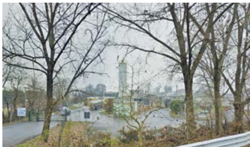
Il depuratore di Mortara
