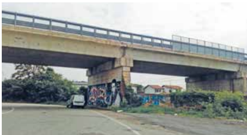
I lavori di consolidamento dovrebbero durare dai sessanta ai novanta giorni
