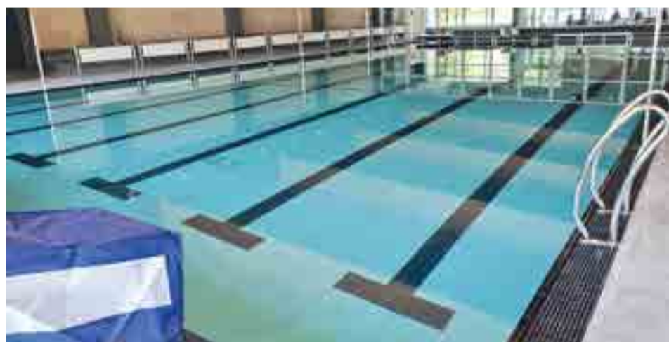
La vasca principale della nuova piscina
